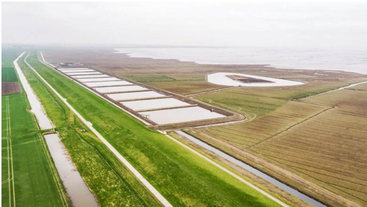
Figuur 4: Brede Groene Dijk met klei van dichtbij in de kleirijperij
