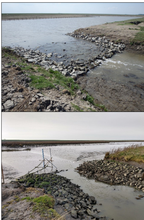
Figuur 2.2 Ontwikkeling van het dwarsprofiel boven over de drempel in de monding van de Klutenplas in de eerste vier jaar na aanleg. De vier profielen zijn niet elk jaar langs precies dezelfde lijn opgenomen. In 2022 is de inmeting van het profiel niet succesvol verlopen. De foto rechtsboven is van 23 mei 2018, een maand nadat de Klutenplas werd blootgesteld aan de invloed van het getij. De foto rechtsonder is van 8 januari 2022 en laat zien hoe de drempel in de loop der tijd door onderloopsheid is aangetast.
