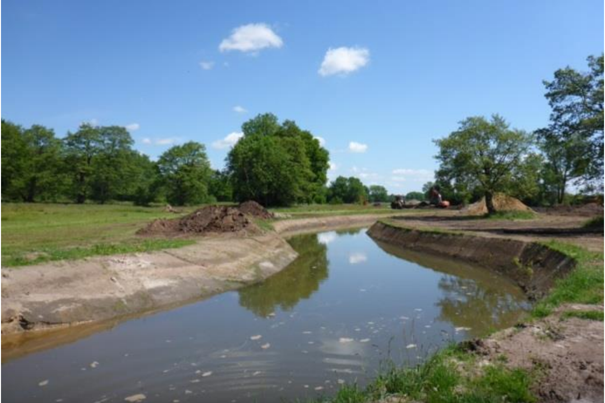
Graafwerk bij de inrichting van het Deurzerdiep, 2015
